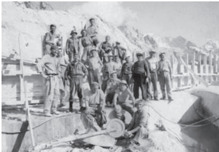
Operai sul cantiere della diga dell'Albigna, in Val Bregaglia, 1955-59 (foto Hans Steiner; ewz / Ciasa Granda, Stampa)
